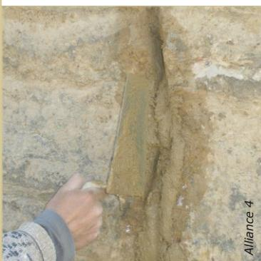
Soigner le rebouchage des fissures. Humidifier et insérer le mortier profondément.
