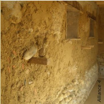
Les murs très abîmés sont rebouchés en béton d'argile. Des pierres ou des adobes sont insérées dans les gros trous.
