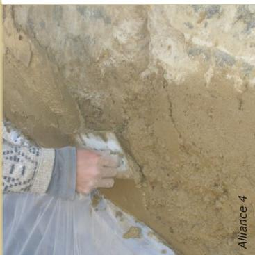
Le béton d'argile s'applique au jeté ou au plateau. Il est envisageable de réaliser plusieurs passes à quelques heures d'intervalle pour recharger les épaisseurs importantes.
