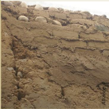
Des adobes (briques de terre crue) sont utilisées pour reconstruire les éléments manquants ou pour boucher les gros trous.
