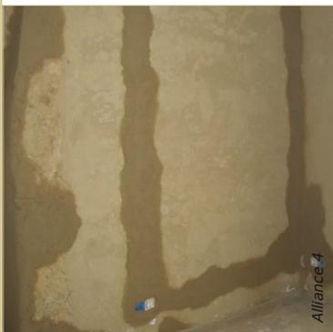
Le béton d'argile sert au rebouchage des saignées techniques et au scellement des boîtiers.
