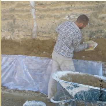
Projeter le béton d'argile à la truelle. Insérer des pierres dans les gros trous. Laisser tirer puis talocher pour bien faire adhérer les bords.
