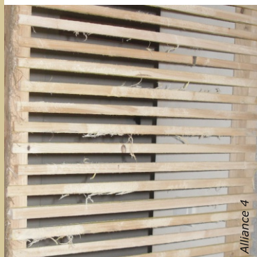
L'ossature est fixée sur le mur existant en conservant un espace de 10 à 20 cm pour le remplissage isolant.
