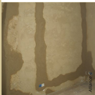
Sur ce mur un pisé, les saignées électriques ont été comblées au béton d'argile, avant application du corps d'enduit.
