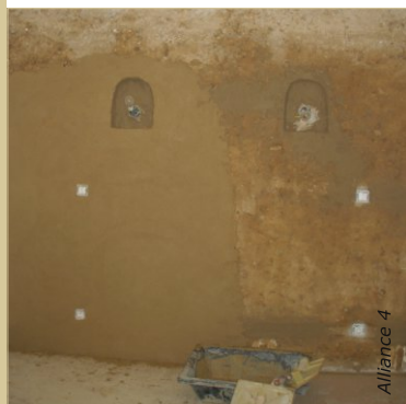
Bien humidifier le support en cours de pose. Soigner l'application autour des prises et des interrupteurs.
