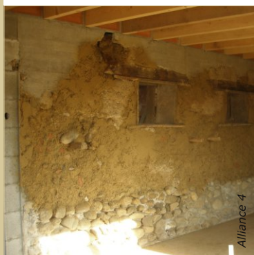
Ce mur nécessite plusieurs préparations : gobetis sur le béton banché et les moellons, jointoiment à la chaux sur les pierres et rebouchage des trous dans le pisé avec du béton d'argile.
