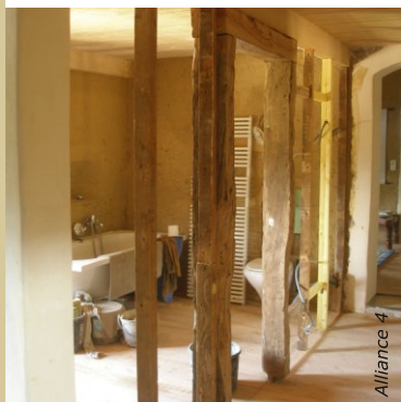
Pose du cadre de porte, des lisses hautes et basses puis fixation des montants intermédiaires tous les 60 cm environ.
