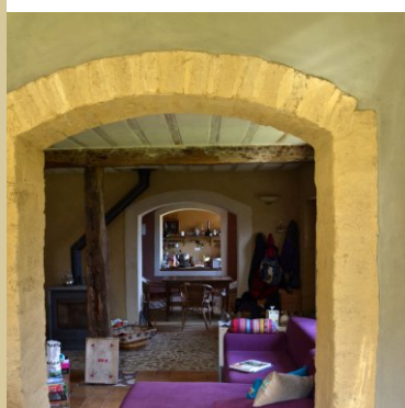
Les adobes sont porteuses. Elles peuvent servir à la construction de jambages et de voûtes.
