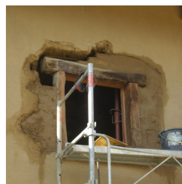
Pour cette ouverture, les adobes ont servi à combler l'espace entre le pisé et le bois, sur les côtés et le dessus du cadre.
